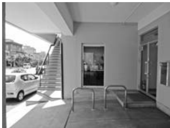
1階貸店舗（西側）入口
