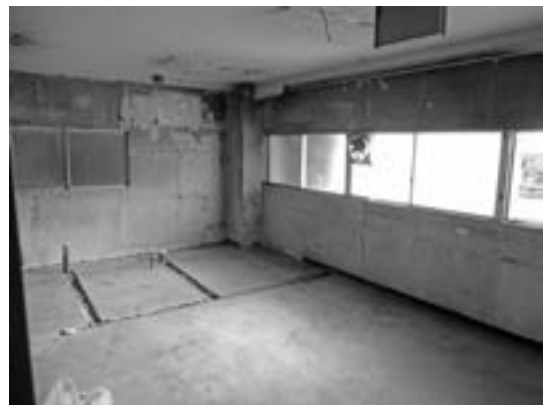
改修工事中（1 階貸店舗東側）
