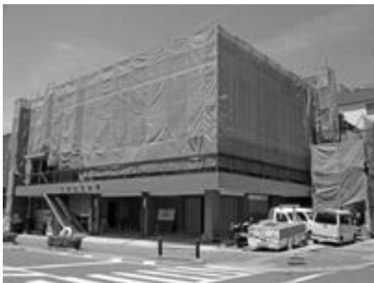
改修工事中の水道会館
