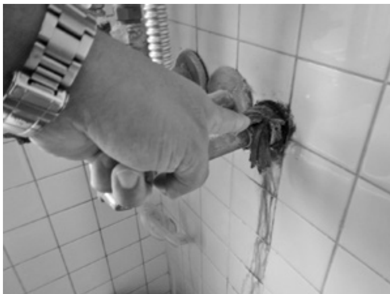
第10回市営保育所水廻り点検（久世保育所） 給湯器水栓の配管劣化
