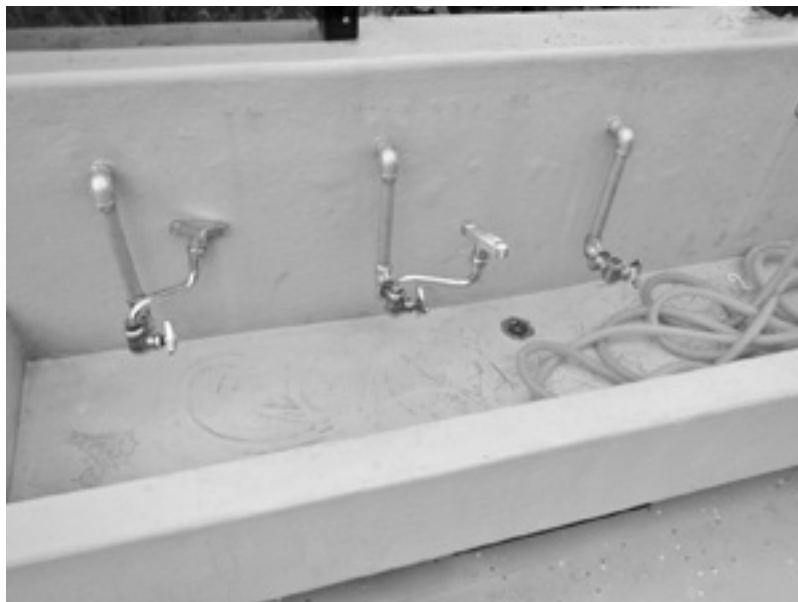
第9回市営保育所水廻り点検 (辰巳保育所) 屋外プール 目洗い水栓吐水口 パッキン樹脂リング無し、吐水管無し
