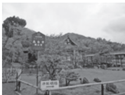
1605年に建築された重要文化財の開山堂。
